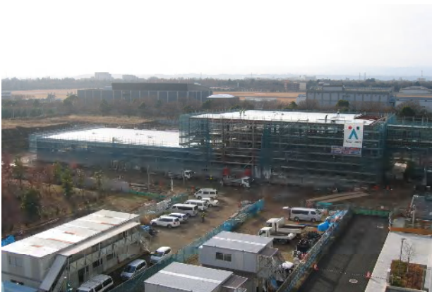
写真2. 極地観測棟：作業室、機材保管庫、倉庫等は南側（写真左）、隊員事務室、南極観測センター等は北側（写真右）。写真は12月11日現在
