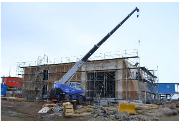
自然エネルギー棟の建設風景
