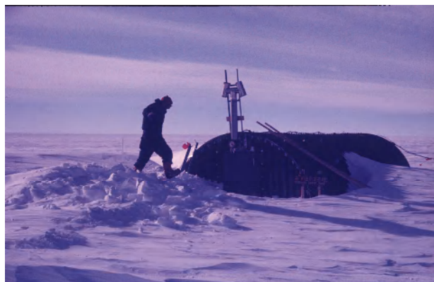
みずほ基地最初の建物（コルゲートパイプ、1970年11月）
