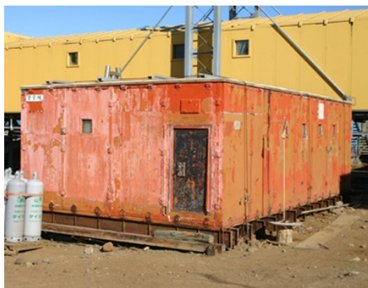
1次隊建設の食堂棟でありCB棟、後の娯楽棟（手前の赤い建物）
