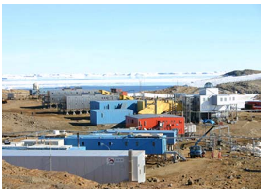
23次・24次隊が建設した発電棟(中程にある赤い2階建ての建物)
