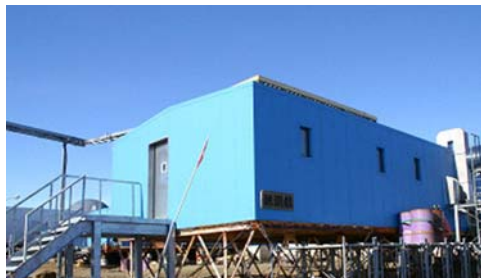
8次に建設された観測棟は、45次隊でガバリウム鋼板による外壁改修工事を施した。新居のように装いを新たにした。
