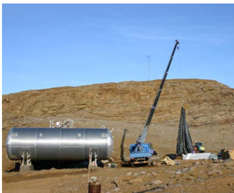
100 kl の金属タンクとターボリン燃料タンクの撤去作業。見晴らし台には現在、7本の金属タンクが連座している。
