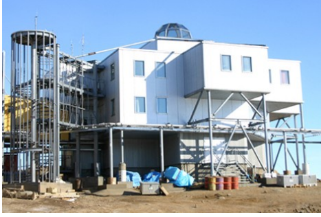
33 次で完成した管理棟。1 階から 3 階まで上に行くほど床面積が広くなるというデザインは南極の基地でも類を見ない。隊長室、厨房、食堂、医務室、娯楽室、図書室、通信室、倉庫がある。
