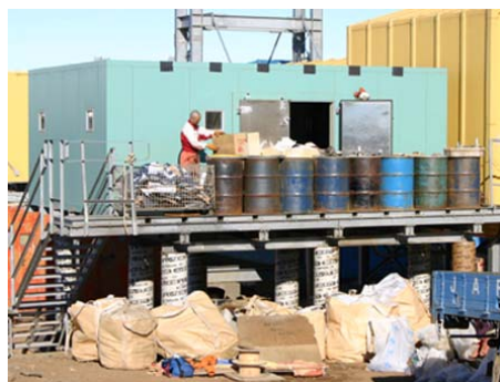
42次に建設した廃棄物集積庫。冷凍庫パネルを改造したものである。
