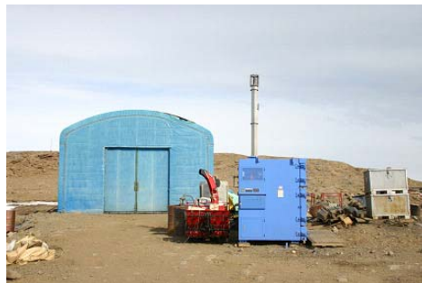
41次に建設した第1廃棄物保管庫。環境問題が深刻になり、この建物以来、廃棄物関係の建物が急増しているのも時代を象徴している。
