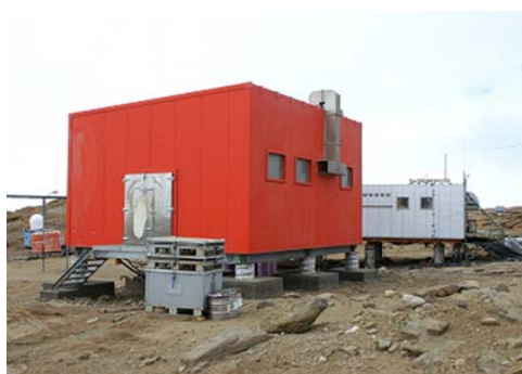
41次に建設した焼却炉棟。焼却炉のほかにも生ゴミの炭化装置が備わっている。
