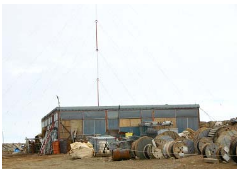
まるで廃棄物の中にうずまるようにしてまだ健在な11次建設の倉庫。居住区から離れた建物で火災を退避できる。生活用品、設営道具、非常食等重要な物資が収納されている。
