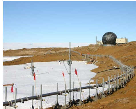
高架式パイプラインから引き継いで地べたを這うように走るパイプライン。見晴らし岩方面まで蜿蜒と続くが、完成までほど遠い。
