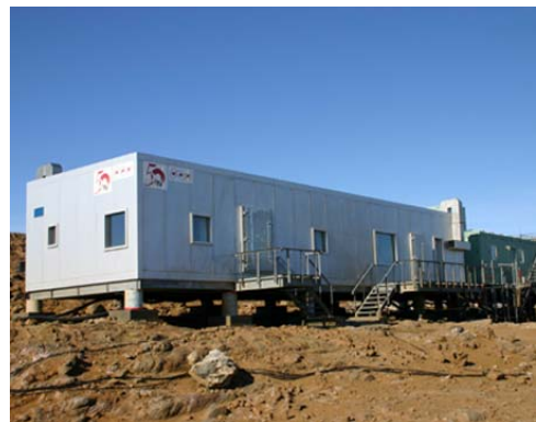
44 次で建設した NHK ハイビジョン TV 放送で活躍した放送スタジオ棟。アンテナは撤去された。風下に衛星受信棟があり、雪ドリフトに悩まされた。
