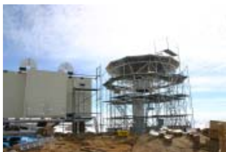
建設中のインテルサットアンテナとシェルター(左)
